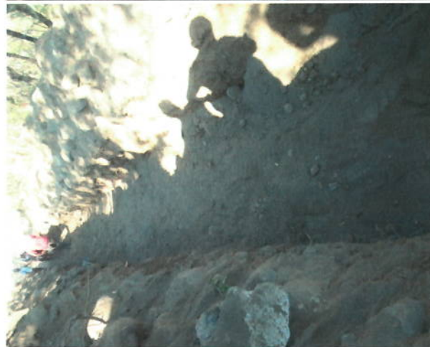
PLANTILLA DE 0.10 MTS CON MATERIAL PRODUCTO DE LA EXCAVACIÓN
