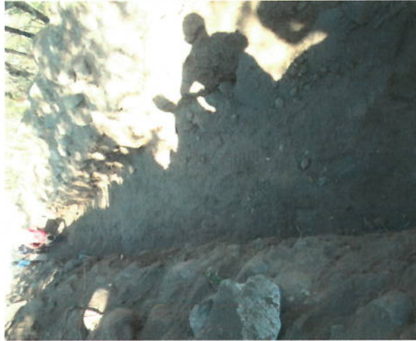
PLANTILLA DE 0.10 MTS CON MATERIAL PRODUCTO DE LA EXCAVACIÓN
